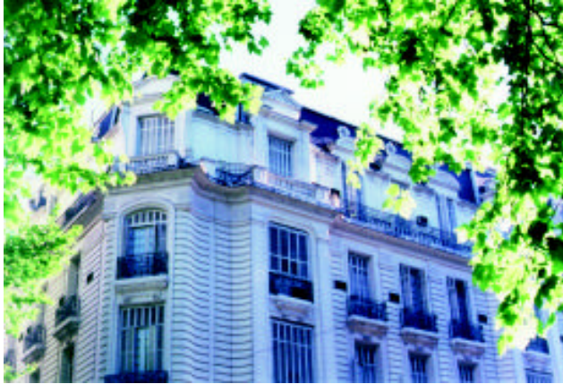
Fotografía 1 Esquina sudoeste de la Av. de Mayo y la calle Tacuarí.
